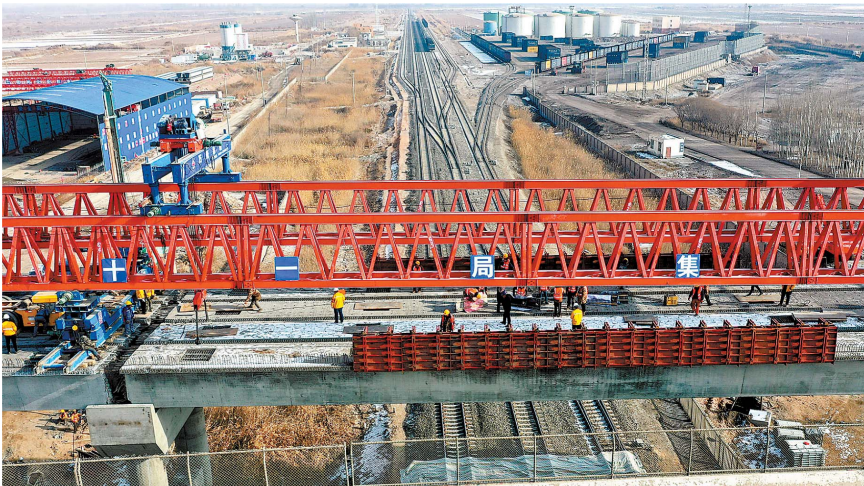
12 - ئاينىڭ 23 - كۈنى، قۇرۇلۇش خادىملىرى قەھرىنان سوغۇققا قارىماي، بىگىتۇەن 1 - شىسىنىڭ 5 - تۈەندىن ئارالغىچە بولغان تاشيولنىڭ جەنۇبىي شىنجاڭ تۆ - مۇرۇبى لىنىيەسىنى ھالقىپ ئۆتەندىغان چوڭ كۆۋرۈكنى ياسىماقتا. 5 - تۈەندىن ئارالغىچە بولغان تاشيولغا سېلىنغان ئومۇمىي مەبلەغ جەمئىي 2 مىليارد 100 مىليون يۈەندىن ئارتۇق بولۇپ، تۈرنىڭ ئومۇمىي ئۇزۇنلۇقى 109.7 كىلومېتىر، ھازىر ئومۇمىي قۇرۇلۇشنىڭ %90 تەمىنلەندى، كېلەر يىلىنىڭ ئالدىنقى يېرىمىدا قاتناش باشلاش مۆلچەرلەنمەكتە.
